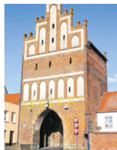
Das Mühlentor in Tribsees kann saniert werden. FOTO: SUSANNE RETZLAFF
